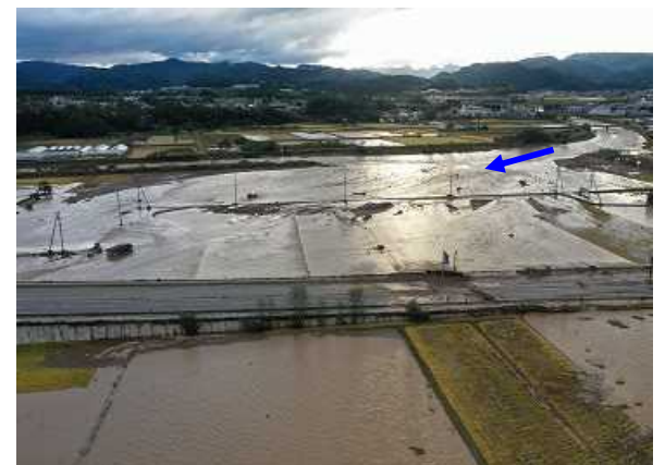
令和元年東日本台風（滑津川 佐久市）
