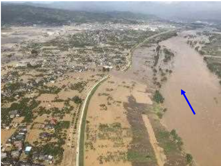
令和元年東日本台風（千曲川 長野市）
