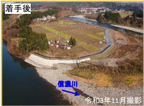
48: 小千谷市 塩殿地区 (信濃川 左岸)
