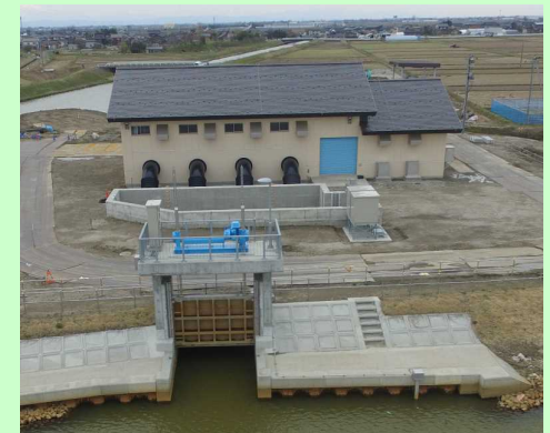
排水機場全景
