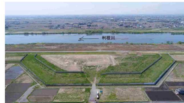
栄地区広域避難地(埼玉県加須市)
