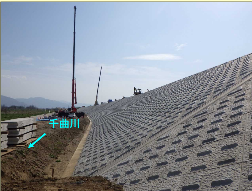
<左2>千曲川津野地区堤防強化工事
