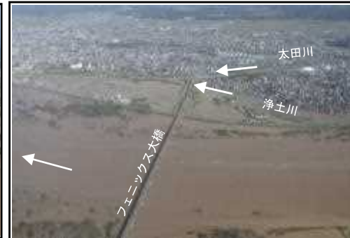
信濃川浸水状況(長岡市今井地先)
