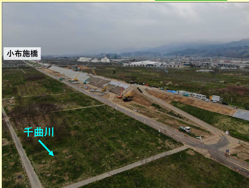
<左6> 吉島地区堤防強化その1工事 令和4年4月撮影
