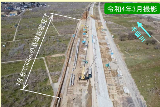
現地施工状況②
