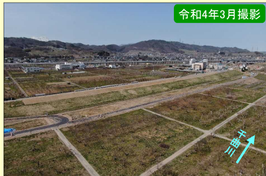
現地施工状況①
