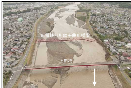
千曲川堤防欠損状況(上田市諏訪形地先)
