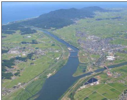
信濃川・大河津分水路を望む
