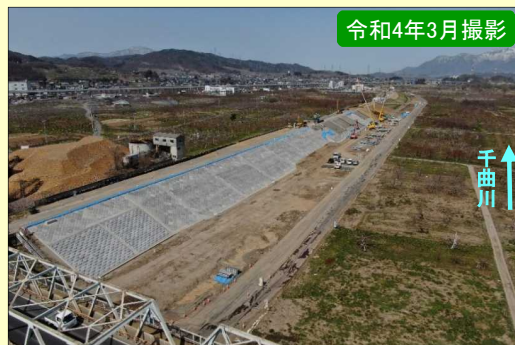
現地施工状況①
