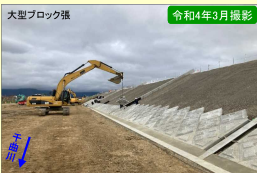
現地施工状況②
