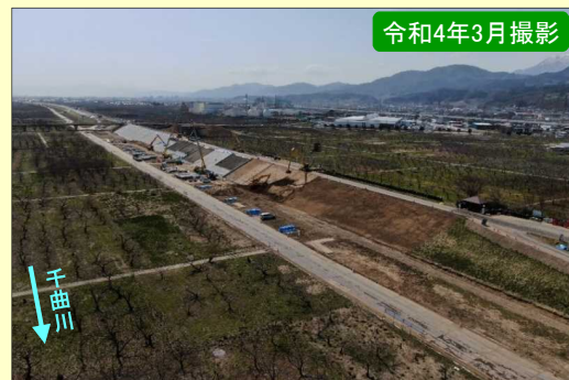
現地施工状況②
