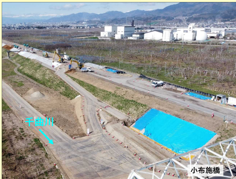
<左5> 飯田地区(左岸)堤防強化工事 令和4年4月撮影
