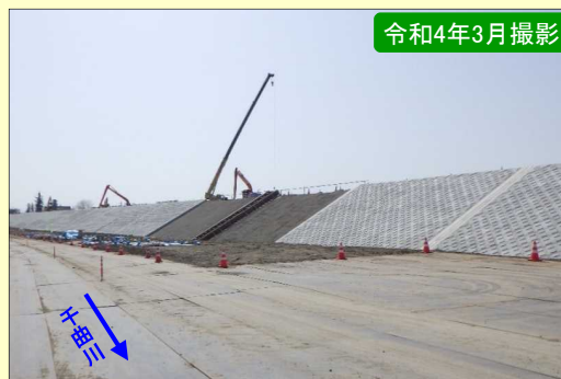
現地施工状況①
