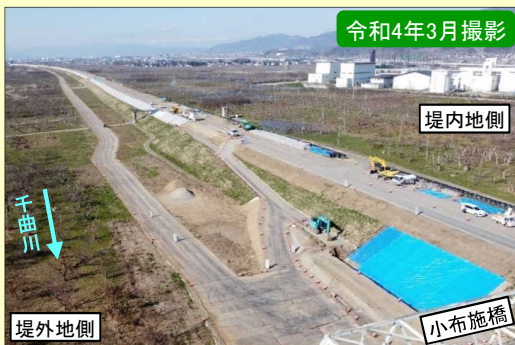
現地施工状況②
