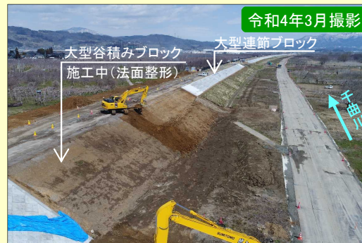
現地施工状況②
