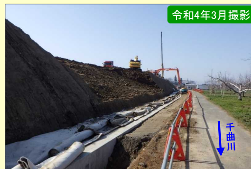
現地施工状況②
