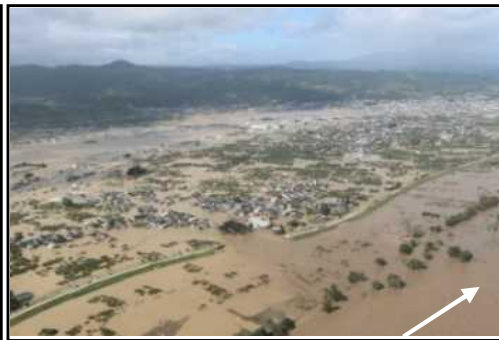
千曲川堤防決壊状況(長野市穂保地先)
