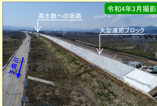
現地施工状況①
