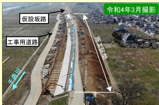
現地施工状況①
