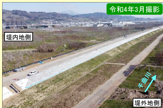
現地施工状況①
