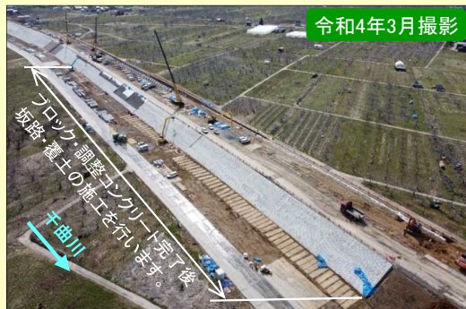
現地施工状況①
