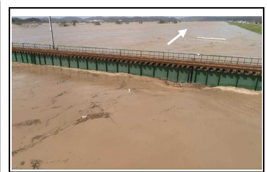
大河津分水路増水状況(JR越後線橋梁)
