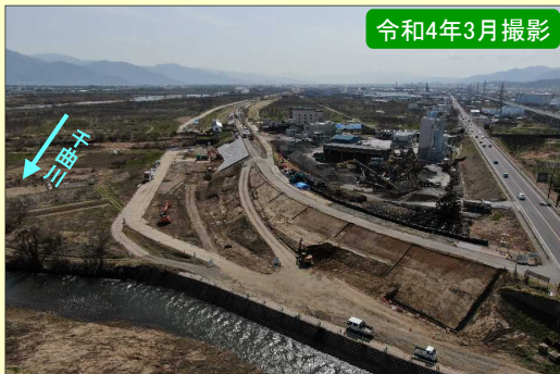
現地施工状況②
