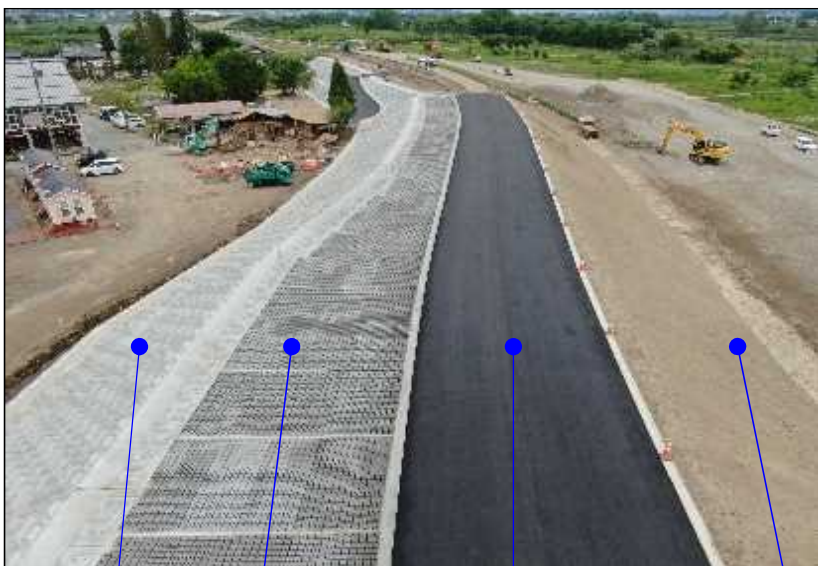
(写真) 施工状況
