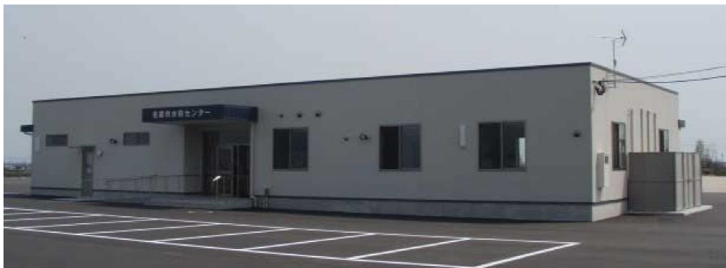
水防センターの事例(嘉瀬川防災ステーション、佐賀県)
