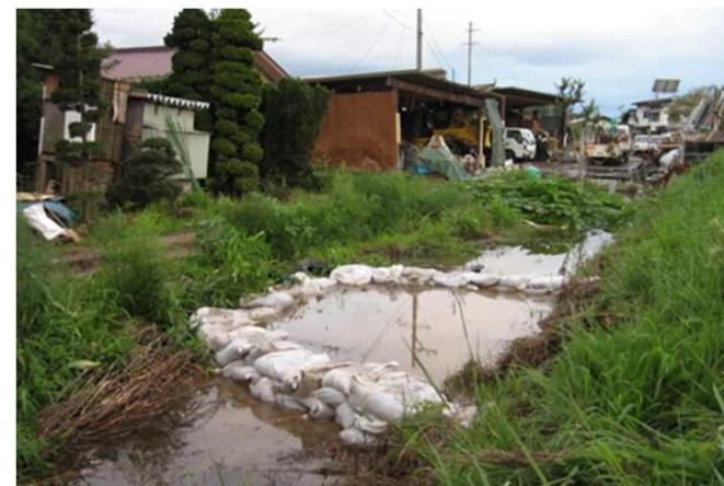
水防団員による水防活動(月の輪工法)
