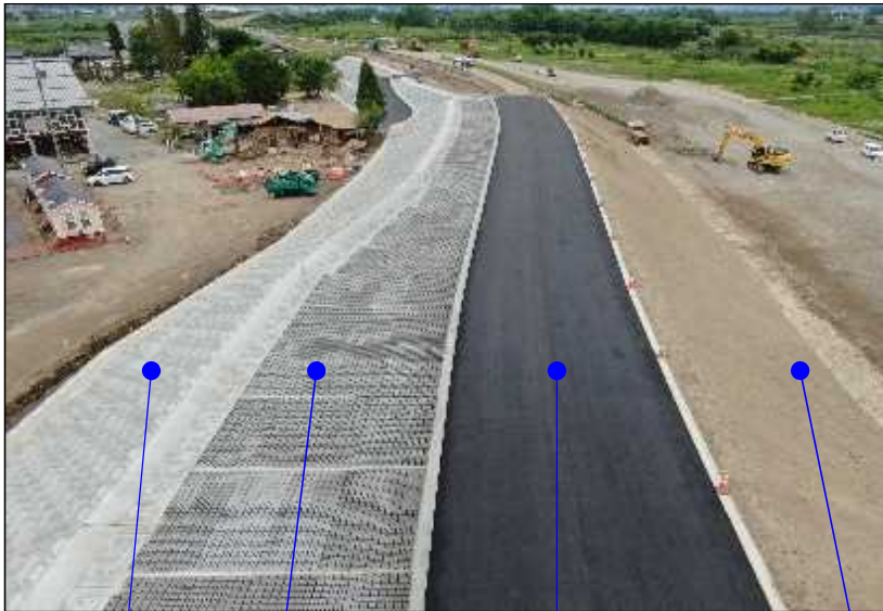
(写真) 施工状況
