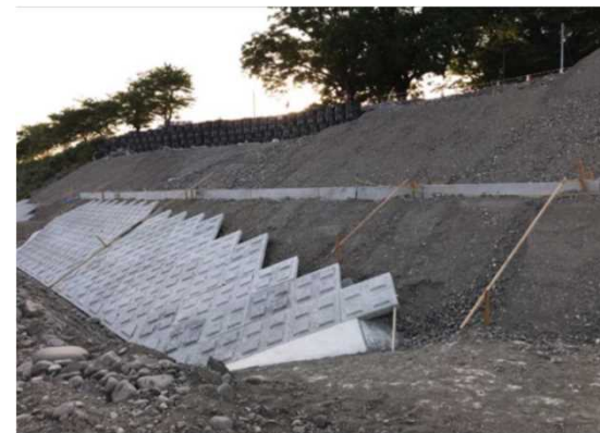
法覆大型ブロック施工状況
