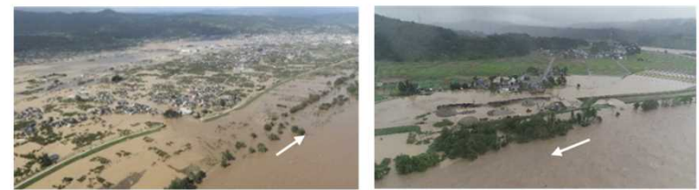
長野市穂保地先の堤防決壊、浸水被害状況 新潟県小千谷市内における浸水被害状況 ※計数については、今後の調査、検討等の結果、変更となる場合がある。
