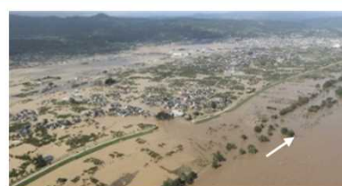
長野市穂保地先の堤防決壊、浸水被害状況
