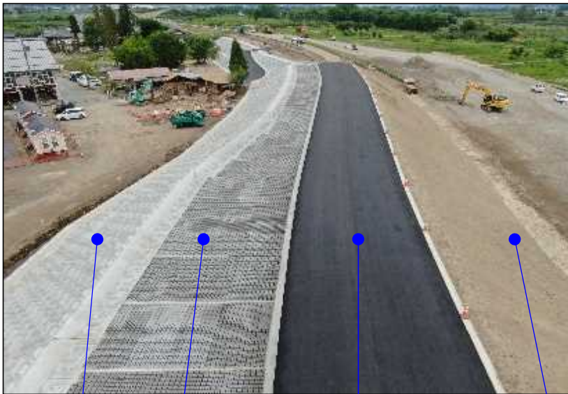
(写真) 施工状況
