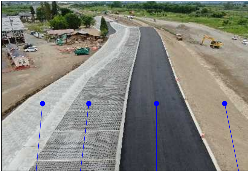
(写真) 施工状況
