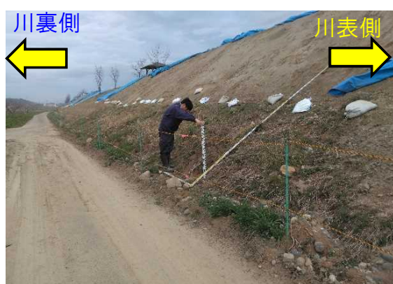
左岸57.0km付近①
