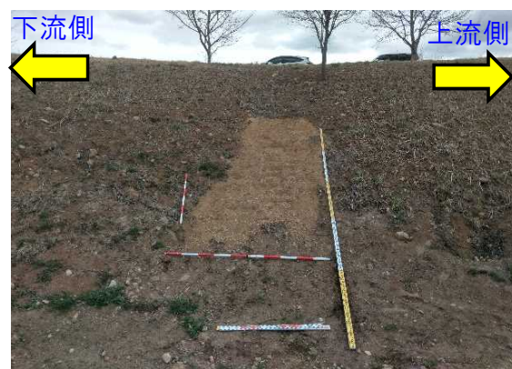
左岸56.75km付近
