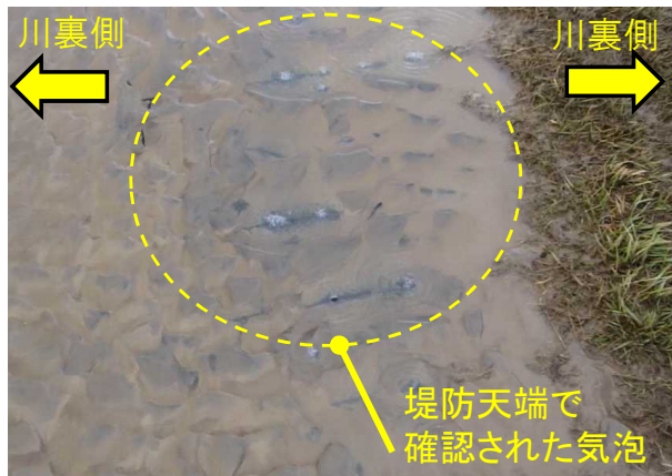
左岸58.00km付近
