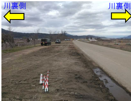
左岸58.00km付近
