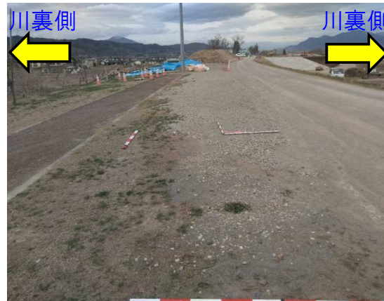
左岸57.75km付近
